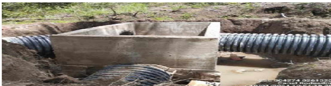
Figura 57. Obra de tubulação do canal Jardim II
